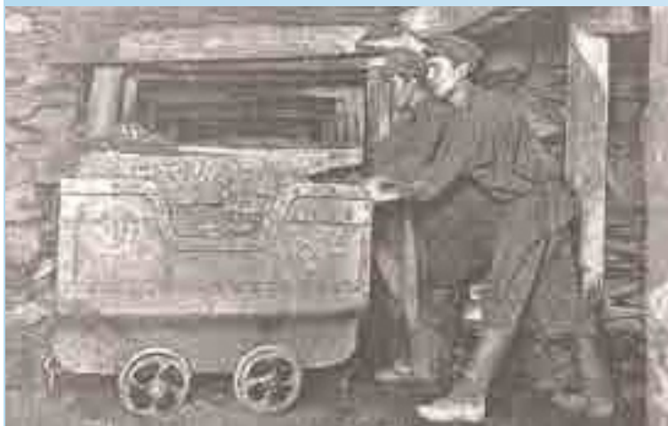
Вагончики с грузенной вагонеткой на площадке при пересечении откаточных
