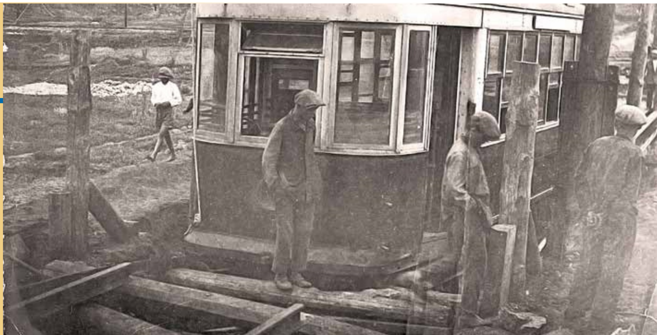
Строительство трамвайной линии. 30-е годы XXв.
