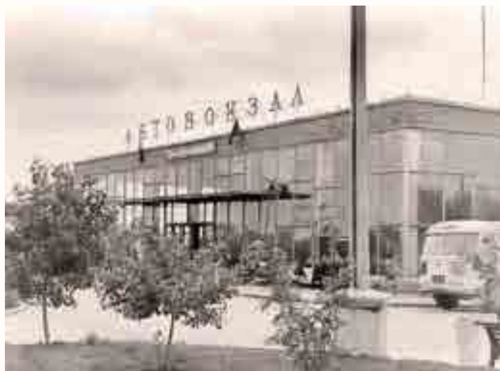
Здание автовокзала. Середина XXв.
