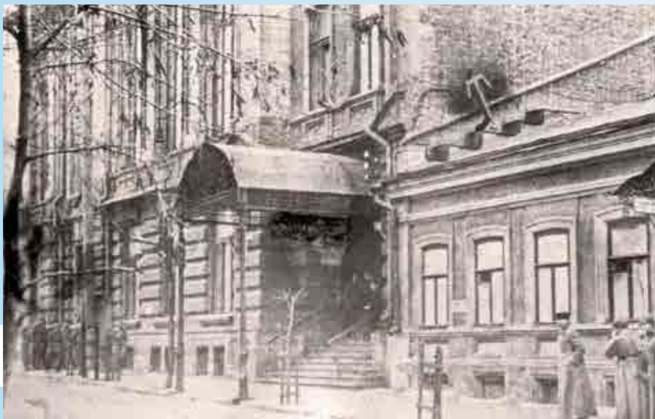
Дореволюционное здание на улице Шевченко. Начало XXв.
