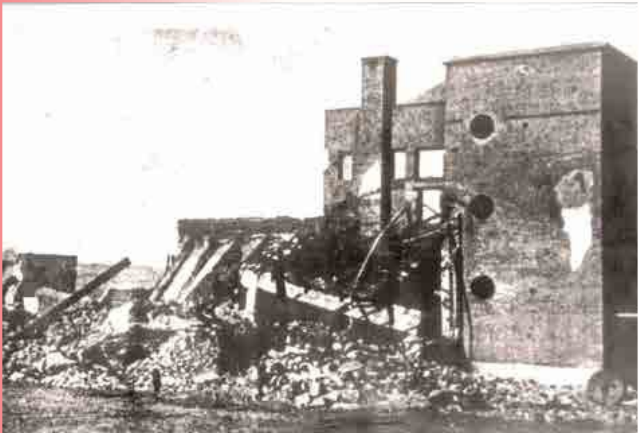
Разрушенный хлебозавод город Шахты. 1943 г.
