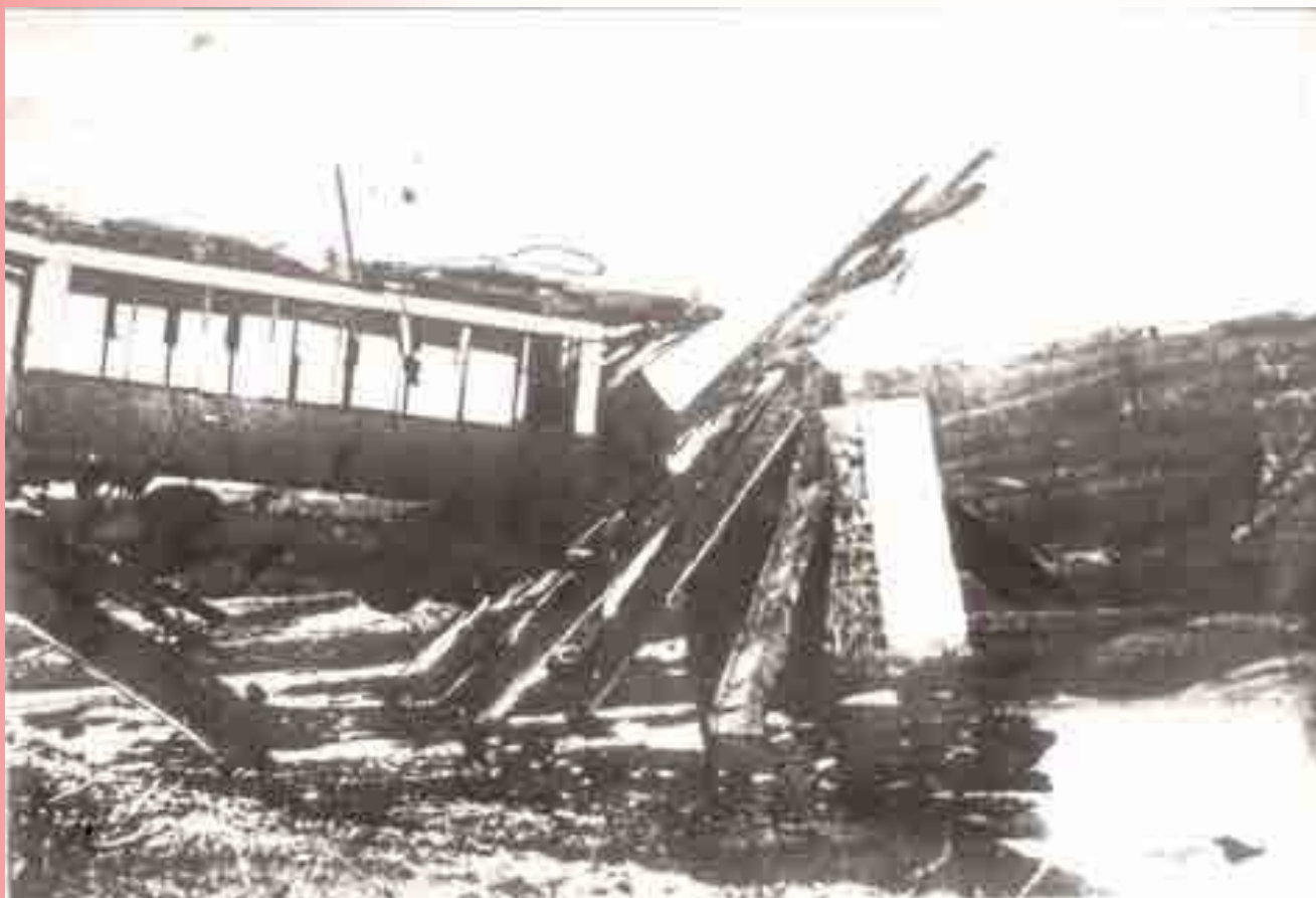
Разрушенный мост через Грушевку. 1943 г.
