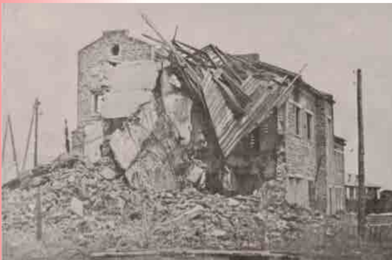
Разрушенная шахта имени Красина. 1943 г.
